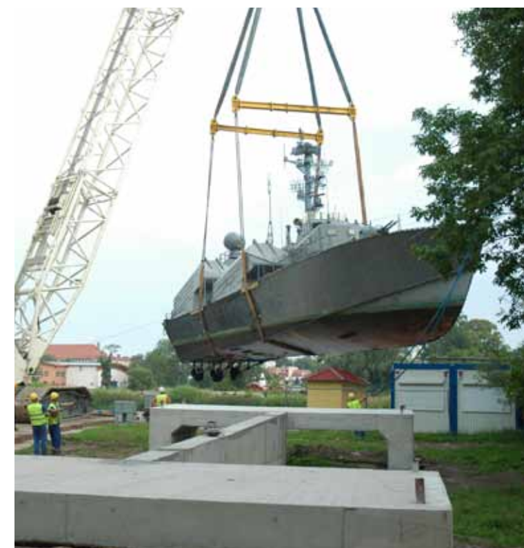
Fundament pod okręty opiera się na 15m palach w głębi ziemi
